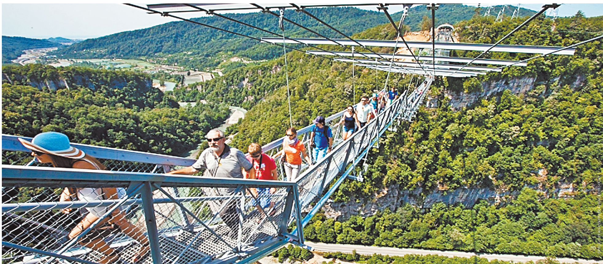
Skybridge в сочинском Скайпарке—самый длинный в мире пешеходный мост. Его длина—439 метров, высота—207. Мост, заявленный в Книгу рекордов Гиннеса, крепится на 8 металлических тросах весом 700 тонн. Он спроектирован так, что способен выдержать 9-балльное землетрясение и, по расчетам, может одновременно удерживать 3 тыс. человек.
