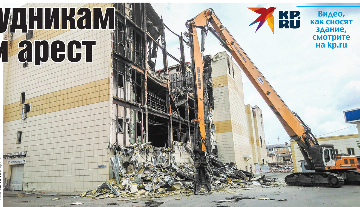
Работы начали с той части здания, которая больше всего пострадала во время пожара.
