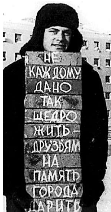
В СССР на стройках работали комсомольские отряды. Сейчас — отряды гастарбайтеров. На фото: комсомолец Е. Мамин на стройке в Надыме. 1971 г.
